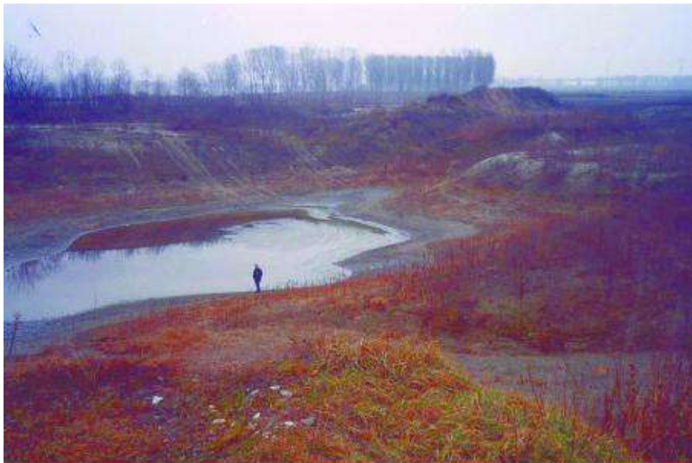
Immagine rottura arginale con formazione di grandi voragini
